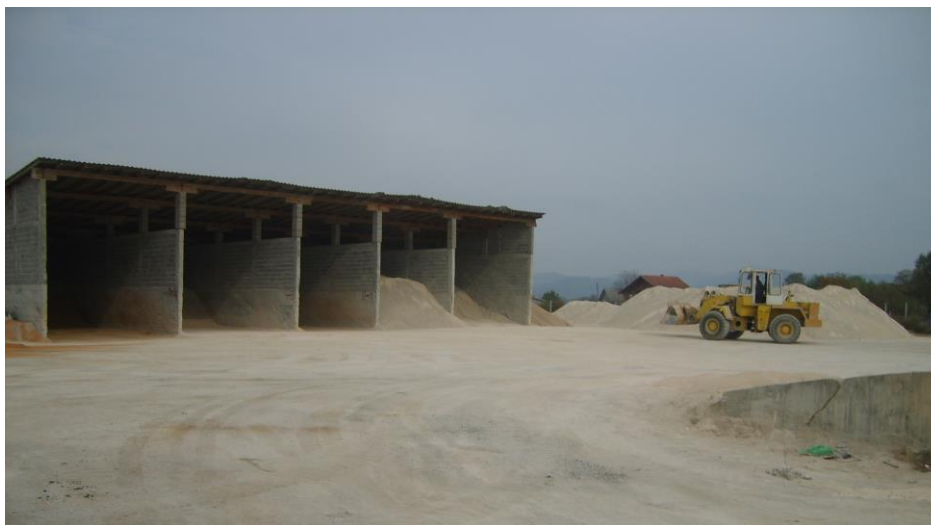
Slika 5.3. Montažni boksovi za skladištenje kamenih agregata
