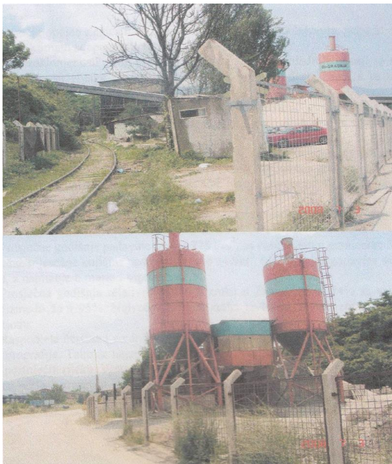
Slika 1.1. Postojeća „stara“ betonara GD „GRADNJA“ d.d. Zenica u Radnoj zoni „Zenica 1“ na parceli k.č. 290/51
