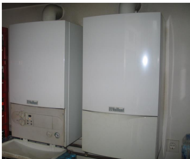
Slika 13. Plinski kondenzacijski bojler Vaillant
