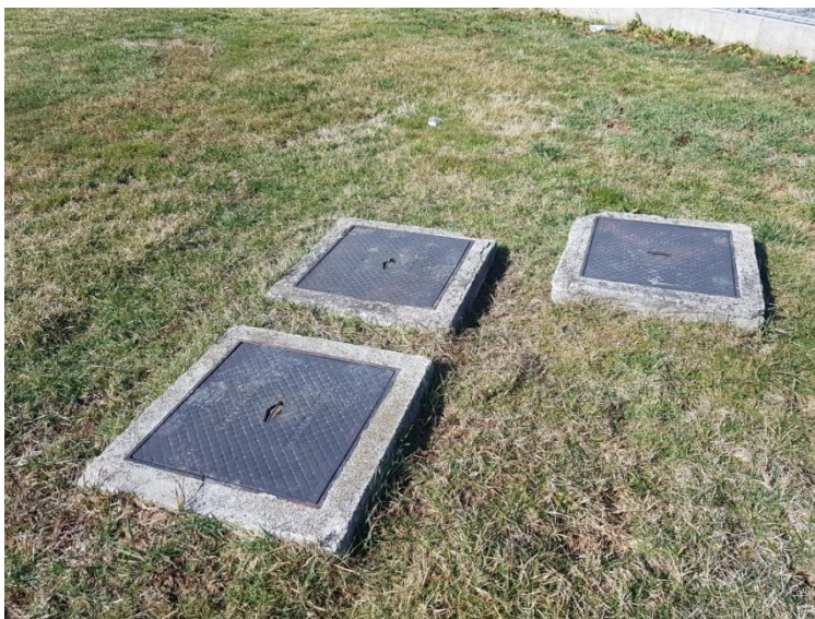
Slika 11. Separatori ulja i masti
