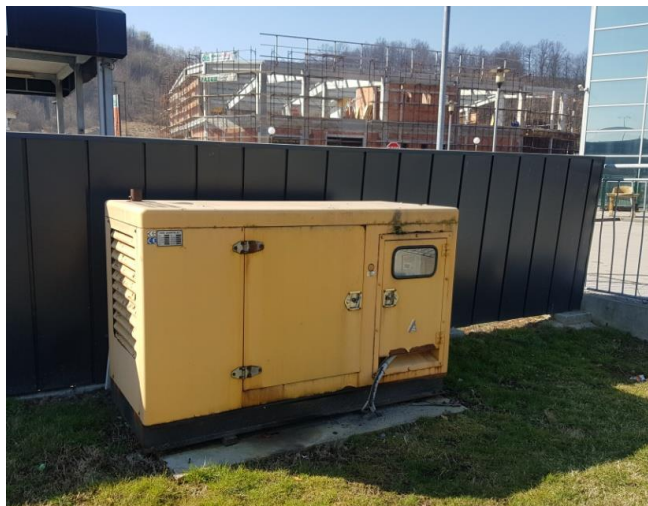
Slika 18. Dizel agregat
