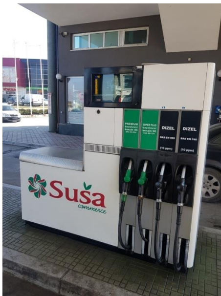
Slika 7. Pumpni automat
