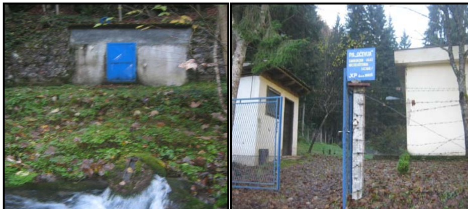
Slika 27: Izvorište Očevija (lijevo) i pumpna stanica (desno) 86
