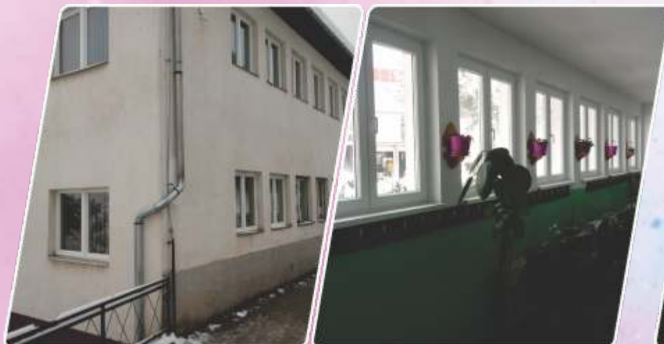
OŠ "Hajderovići" Zavidovići Centralna škola
