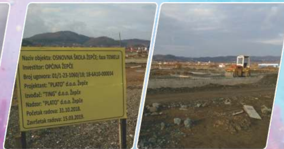
OŠ "Žepče" Žepče Prva faza radova na izgradnji nove škole
