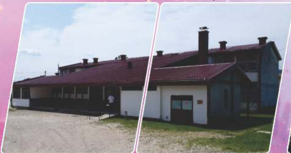
OŠ "Novi Šeher" Maglaj Rekonstrukcija krova na objektu
