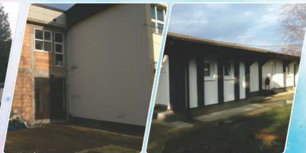
Mješovita srednja škola Žepče Rekonstrukcija i izgradnja radionica
