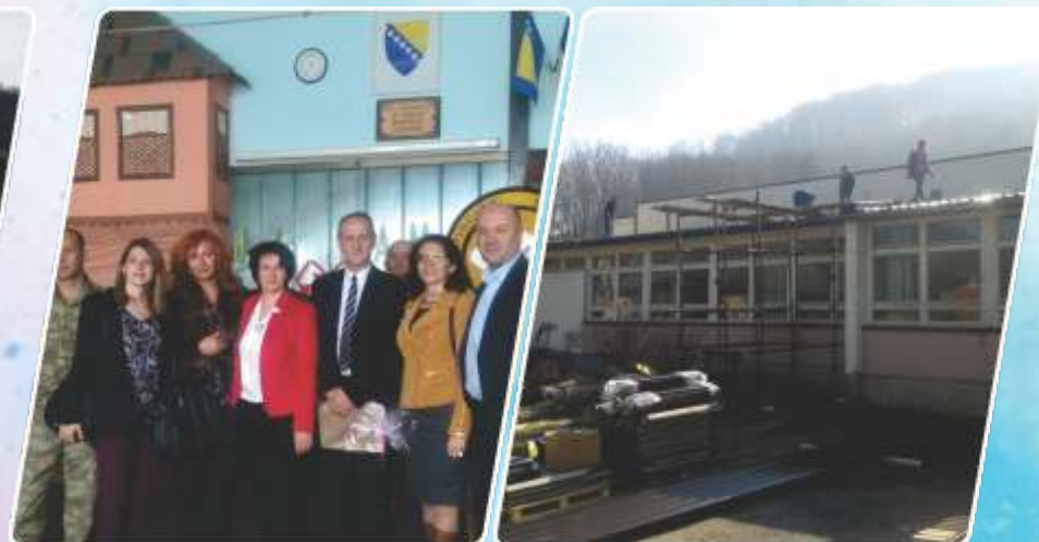
OŠ "Alija Nametak" Visoko Zamjena krova i prozora
