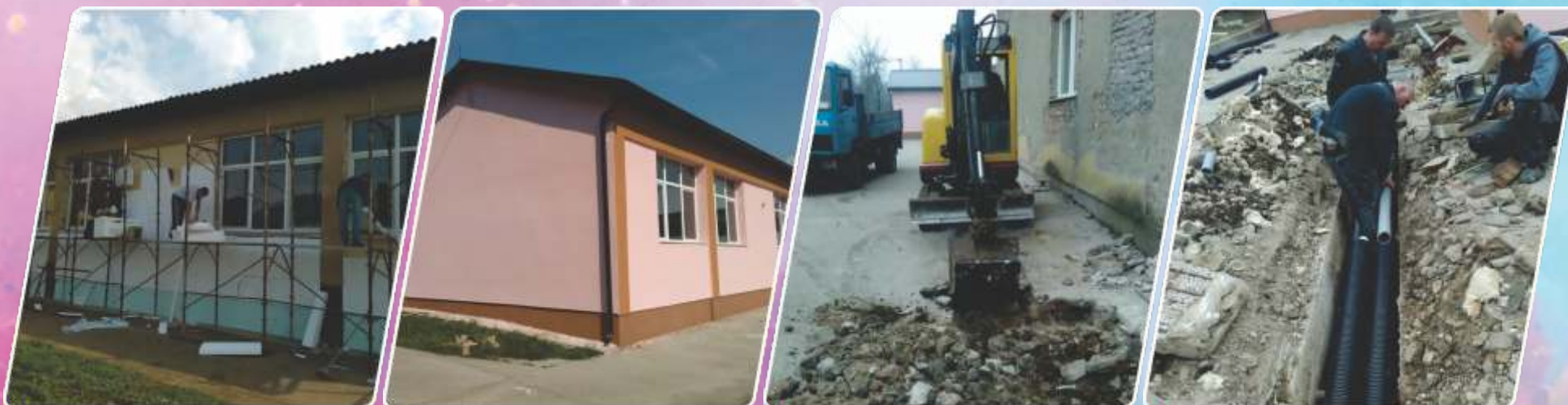
Osnovna škola "Aleksa Šantić" Zenica Utopljanje objekta i zamjena toplovodnih cijevi
