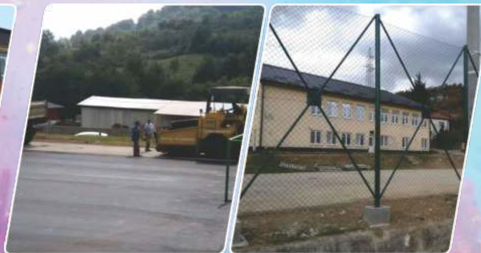
OŠ "Ahmed Muradbegović" Zenica Područna škola Pojske - Rekonstrukcija škole i izgradnja ograde
