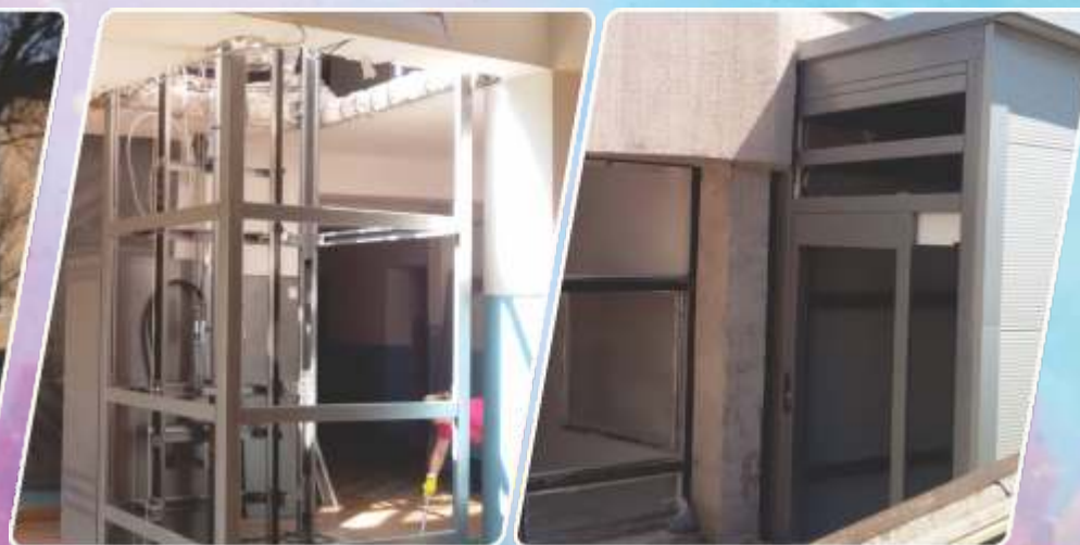
Područna škola Blatuša Izgradnja lifta za učenice sa cerebralnom paralizom
