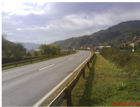
Fotografija 1.14: BM MA1, pogled prema Žepču
