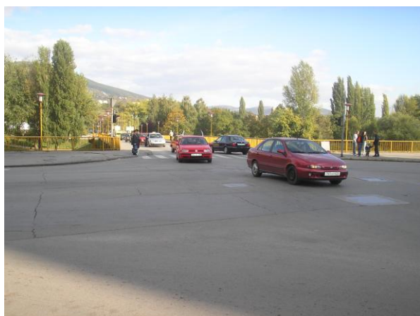
Fotografija 1.62: BM ZE2, pogled iz raskrsnice prema Kamberovića mostu
