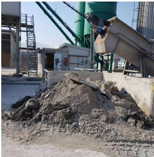
Slika 18. Materijal iz postrojenja za reciklažu „škart“ beton
