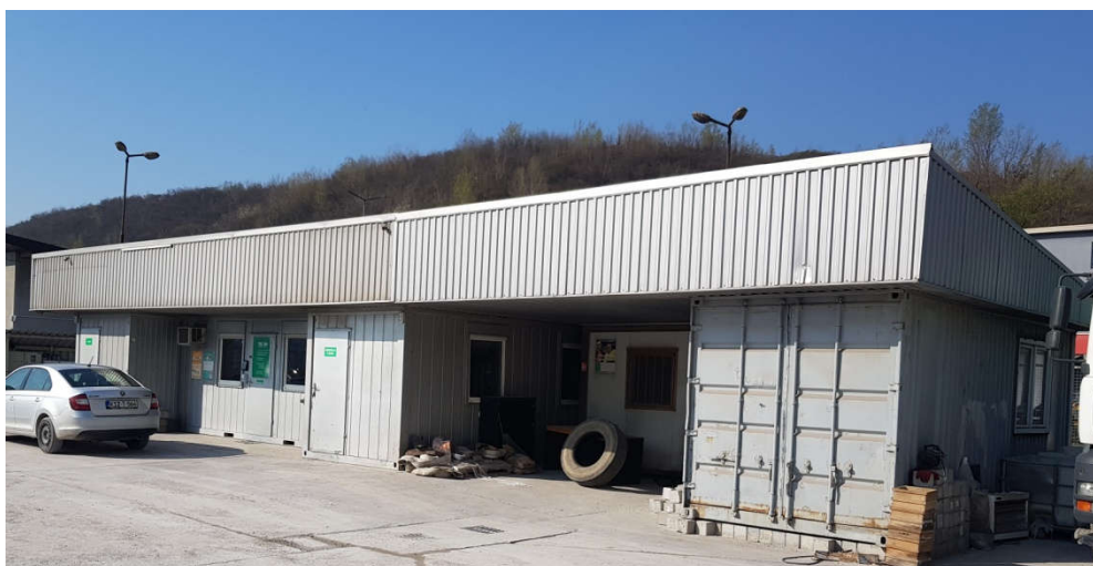
Slika 9. Raspored kontejnera na betonari
