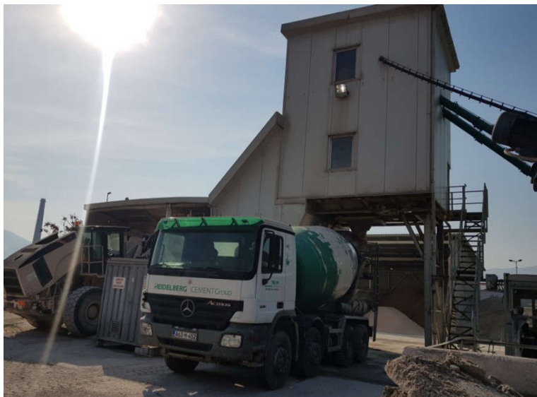
Slika 7. Masa betona se gravitaciono istresa direktno u automikser
