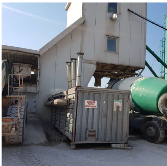
Slika 12. Kotlovska postrojenja se koriste za zagrijavanje betona
