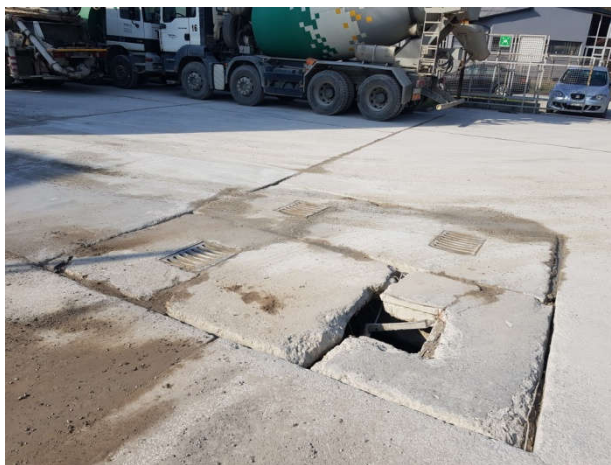
Slika 11. Sistem rešetki za skupljanje oborinskih voda
