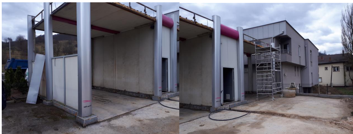
Slika 2. Prikaz autopraonice benzinske pumpe MAHIR d.o.o. Visoko
