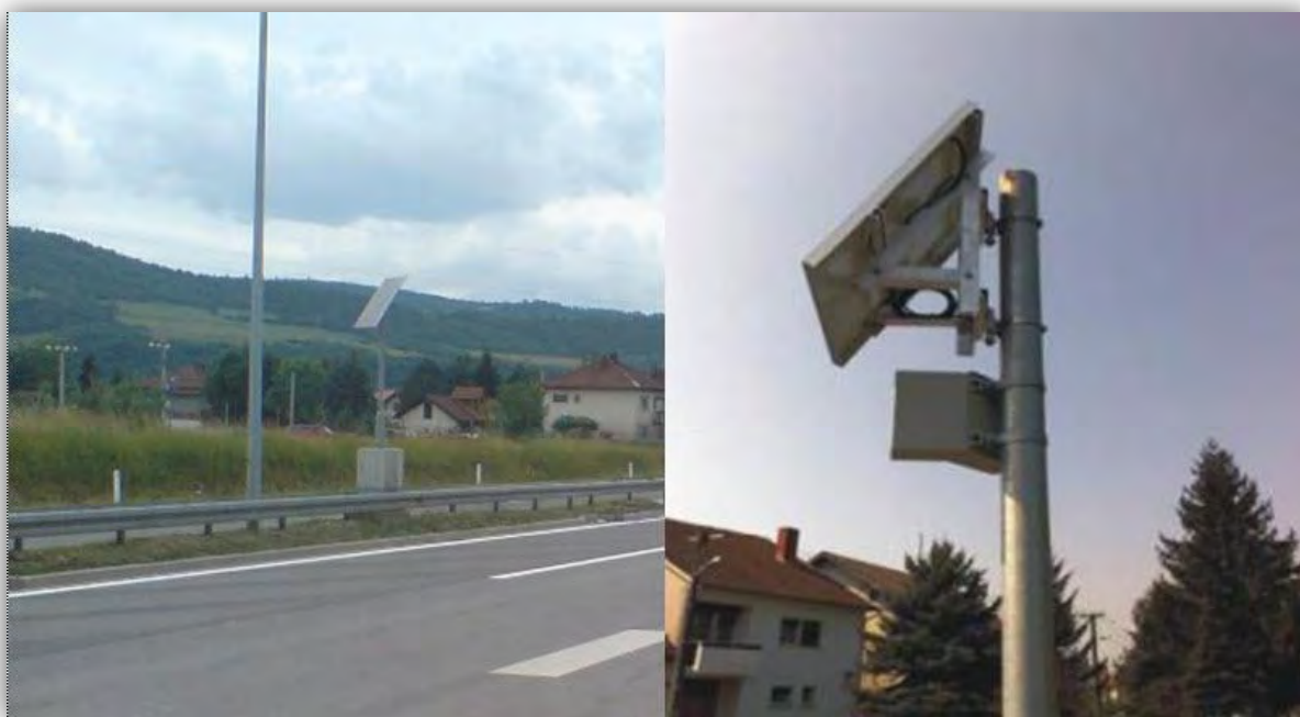
Slika 1.2.1. Solarno napajanje brojača prometa
