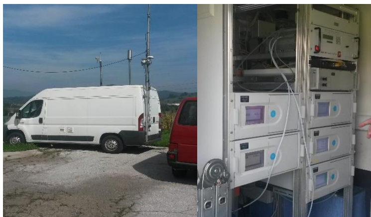
Slika 2. Mobilna automatska stanica za monitoring kvaliteta zraka
